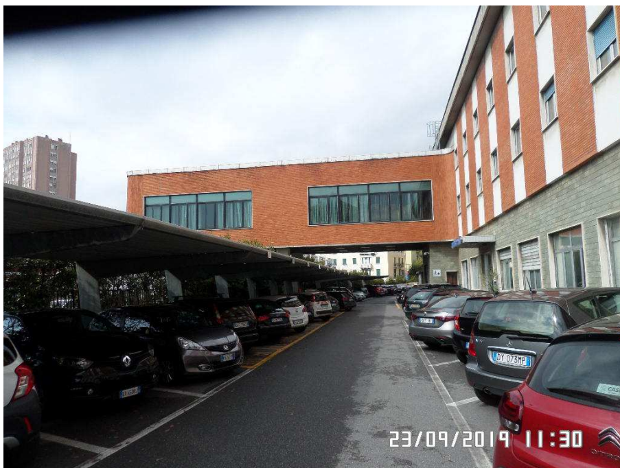
Figura 3: Vista prospetto est corpo a ponte
