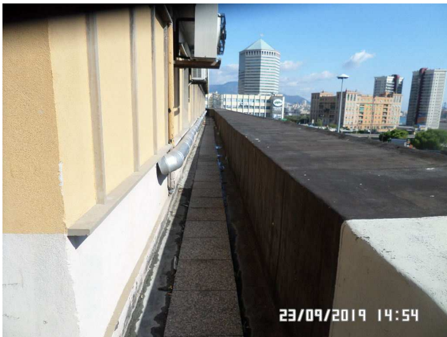
Figura 5: Vista corridoio terrazza al terzo piano
